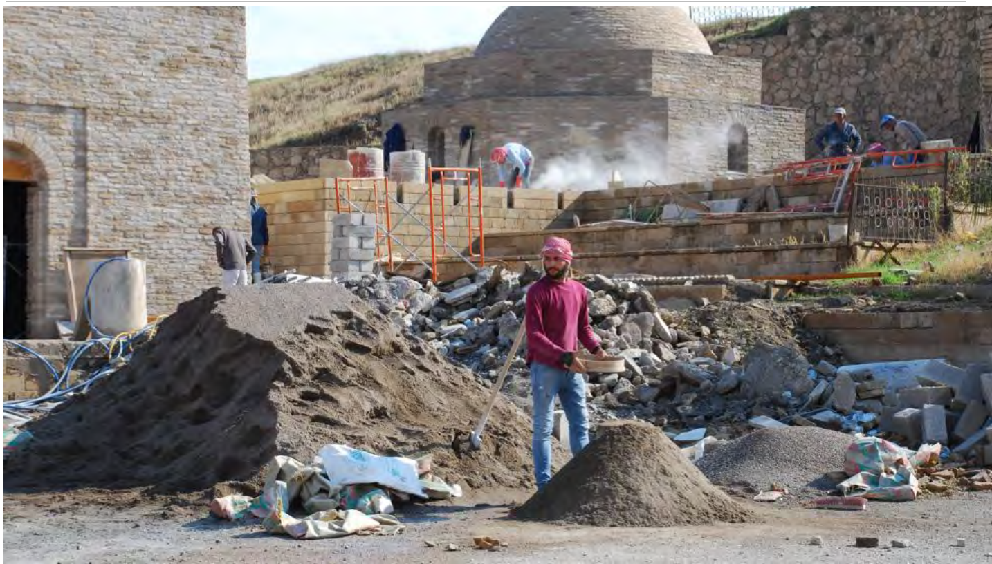
Los trabajos de reconstrucción del santuario de Behnam y Sara (Marís Diéguez)
